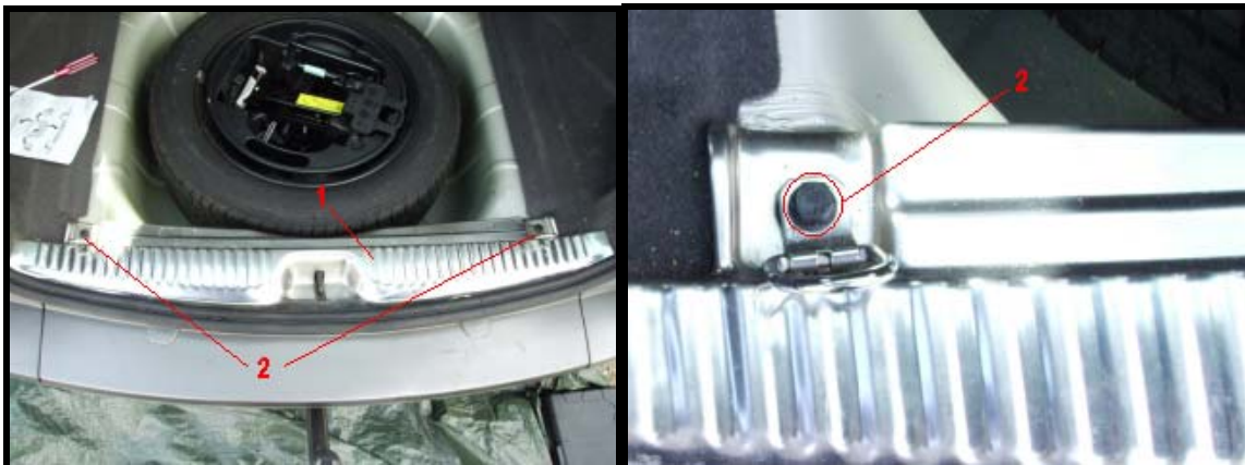
Figure 27 : Photos de la protection du câble de liaison entre les blocs de feux.
