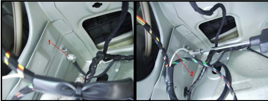
Figure 38 : Photos illustrant le branchement à la terre.
