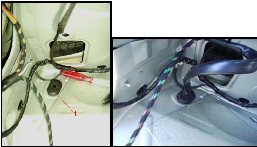
Figure 37 : Photos de la pièce assurant le passage du câble et du câble.
