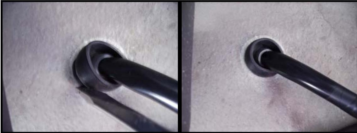
Figure 42 : Photos de la fixation du joint.
