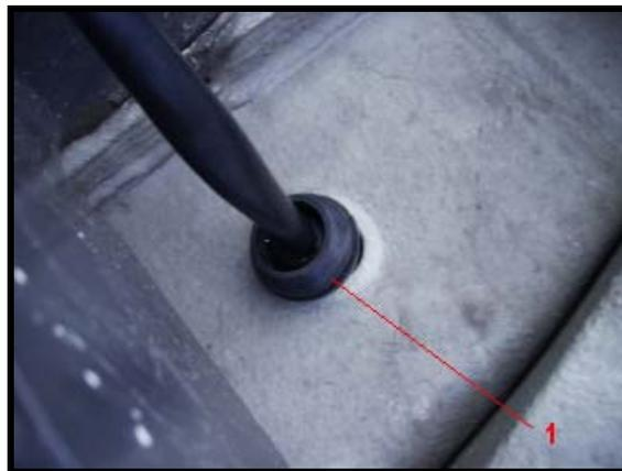
Figure 32 : Photo du joint et du passage de câble.
